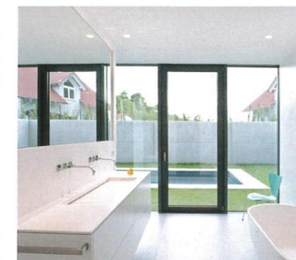
Dämmstärke im Bereich des Flachdaches beträgt 40 cm. Die Glasfassade erhielt eine Dreischeiben-Isolierverglasung. Alle Gebäudeteile wurden am Übergang von innen nach außen konsequent thermisch getrennt. In enger Zusammenarbeit mit Anbietern wurden neuartige Detaillösungen entwickelt und teilweise unter Verwendung von Prototypen umgesetzt.
